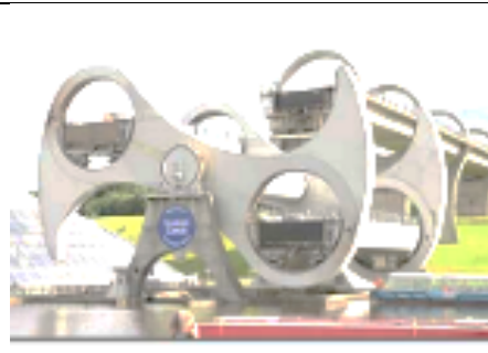
Mise en rotation de la roue, chaque bassin reste horizontal.
